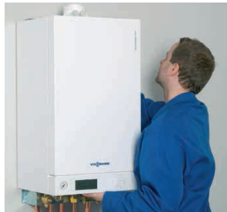
2. Montage de la chaudière
